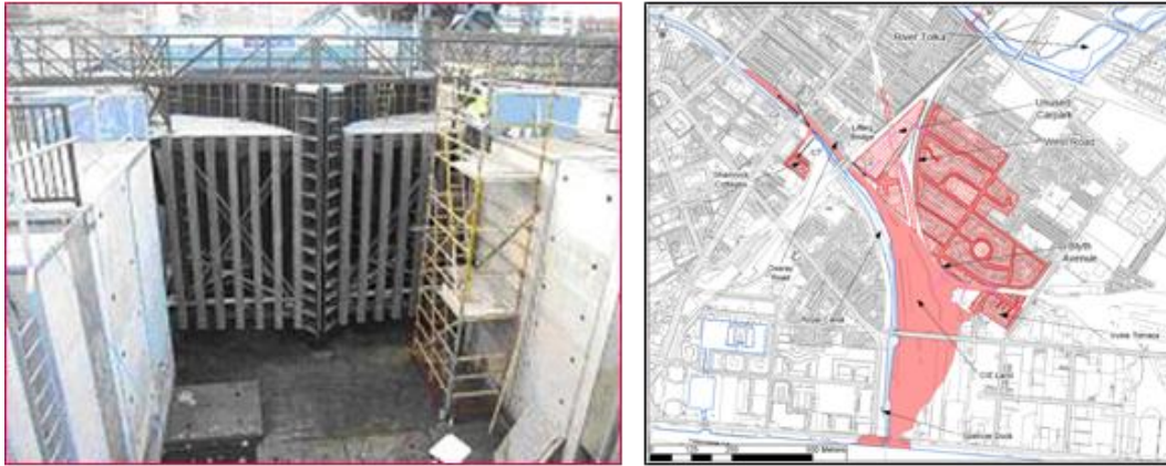
Figure 9.12 : Les travaux effectués sur les vannes du Spencer Dock (à gauche) et les réflexions d'aménagement accompagnant ces travaux (à droite) (Leahy, 2009).
