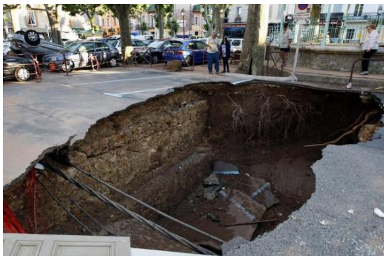
Figure 1.10 : Effondrement d'une chaussée dans un Parking menaçant les réseaux techniques dans le Var après les inondations de Juin 2010.
