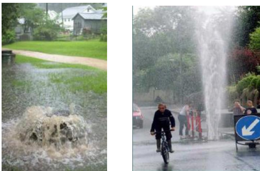
Figure 9.10 : Un réseau d'évacuation des eaux pluviales régulièrement dépassé (Leahy, 2009).
