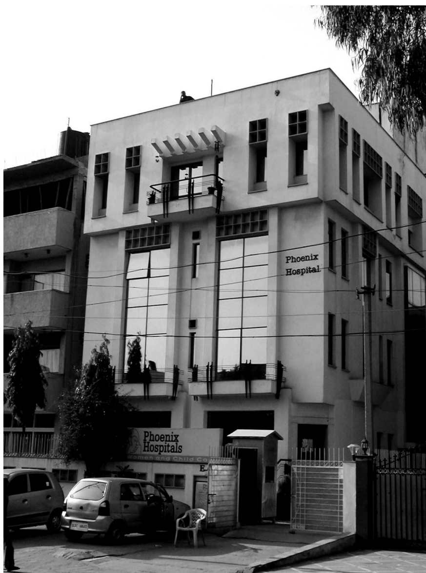
Illustration 15: Phoenix Hospital, un hôpital de quartier
