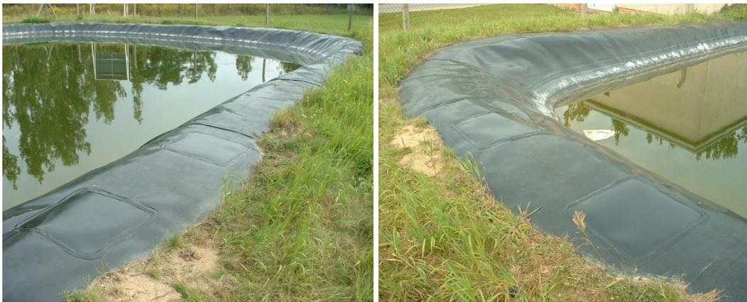
**Figure V-1 : Bassin de stockage d'eau avec la zone de prélèvement supérieure exposée aux UV (GMB A).**
