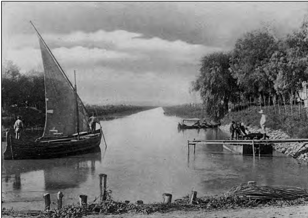
Figure 38 : Canal "Regele Carol" au début du XX e siècle, creusé au sud du bras de Sf. Gheorghe afin d'accroître le transfert des eaux de celui-ci vers le lac Razim. Source : Antipa (1910)
