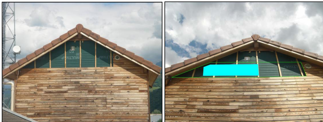
Figure 8 : Face ouest de la cellule une fois la partie supérieure du bardage démontée (gauche) et identification de la surface utilisée pour la mesure d'absorptivité (droite)
