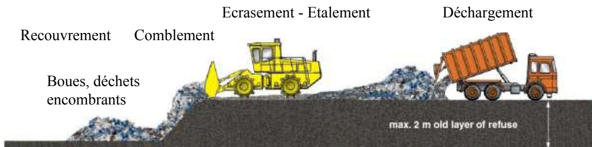
Fig. 10. Techniques du compactage des déchets (© BOMAG)
