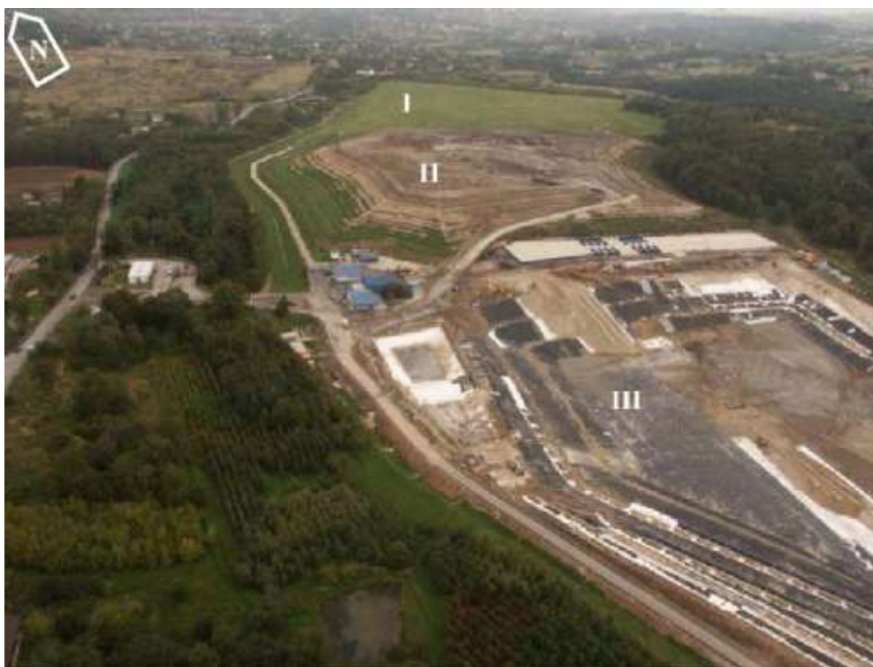
Photo 4. Vue « à vol d'oiseau » du Centre de Stockage Barycz (© Photo MPO, Kraków) I-partie recultivée; II-partie en exploitation; III-partie ouverte dernièrement
