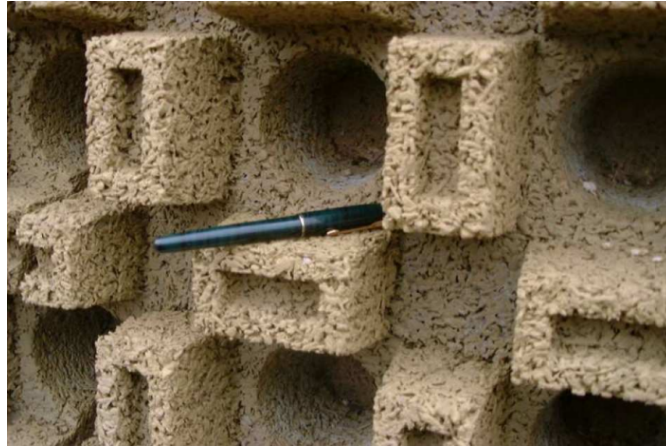
FIG. 6.1 – Exemple de mur anti-bruit à structure fractale (©Colas)
