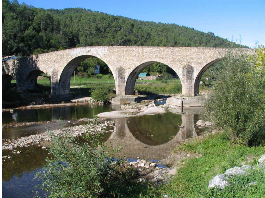
FIG. 9.1 - Vue générale du site test sur le Gardon d'Anduze (Vieux pont de Saint-Jean-du-Gard)
