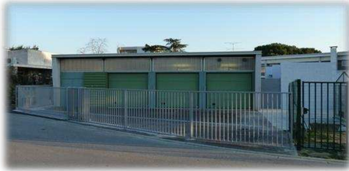
b) Bâtiment A vu de l'extérieur et zone de stockage des gaz
