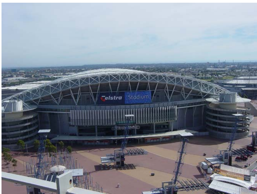
Figure 2.12 : Le Telstra Stadium a accueilli les épreuves d'athlétisme et les cérémonies des Jeux de 2000. Sa capacité est passée de 120 000 à 80 000 spectateurs après les jeux : 2 tribunes latérales ont été démontées pour assurer une meilleure rentabilité du site. (photo GB)
