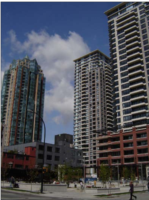
Figure 5.18 : Absence de parking en surface, colonisation du front de rue par un bâti R+3, R+4 et parc urbain – quartier de Downtown South (photo GB).
