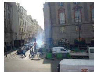
3- Travaux quai de Seine (Rive gauche)
