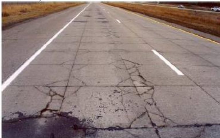
Figure 20: Endommagements types « en coin de dalle » de chaussées BMCB testées in situ (Rasmussen et Rozycki, TRB2004)
