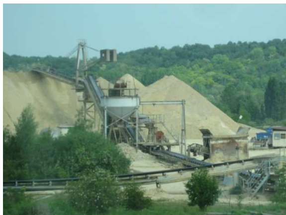
Installation principale d'extraction de la carrière Stockage des granulats
