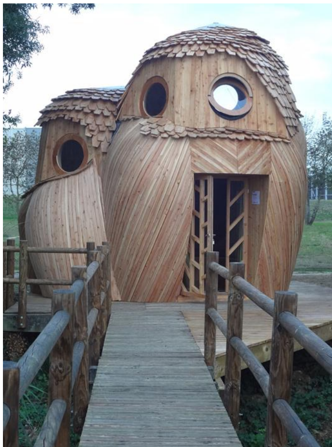
Figure 16 Refuge péri-urbain Les Guetteurs, Bègles
