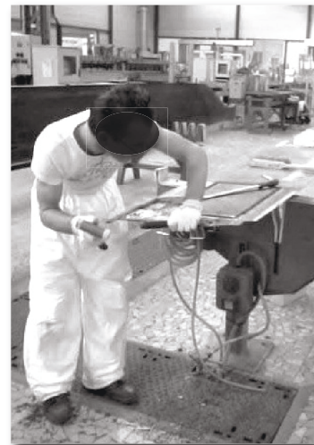
Figure 23 : Déconstruction avec marteau et ciseau
