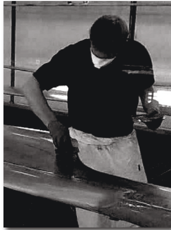
Figure 25 : Imprégnation du mastic bleu
