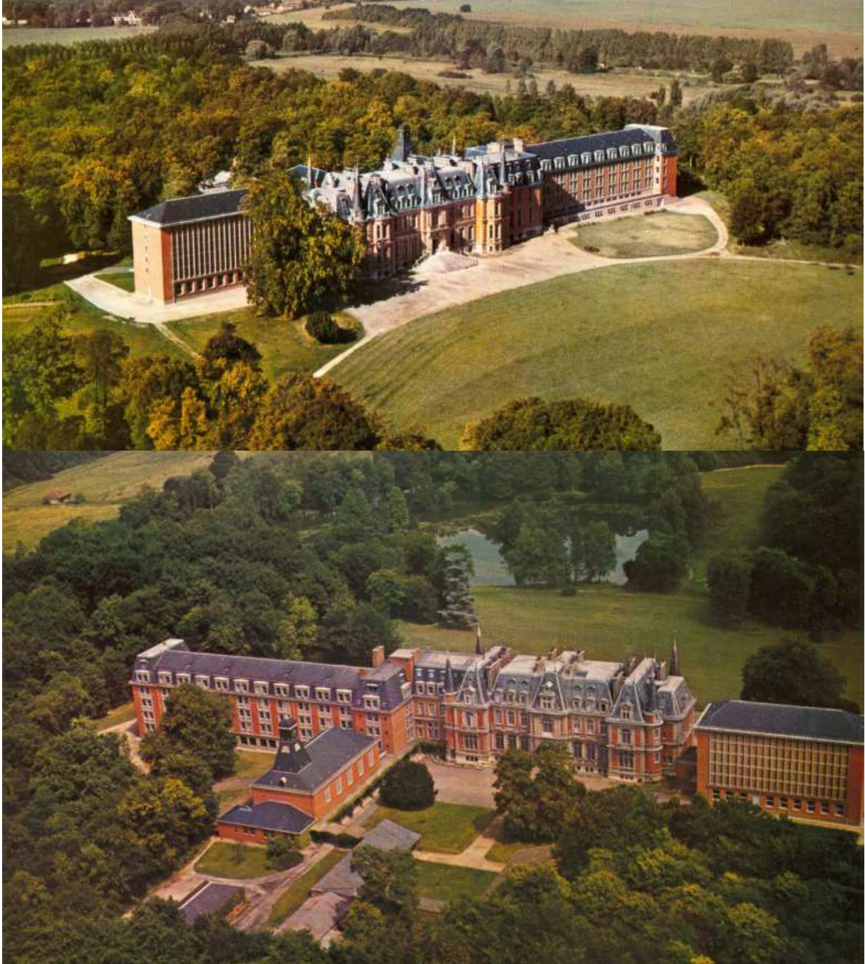
Les Fontaines avec l'aile des scolastiques, la bibliothèque et la chapelle
