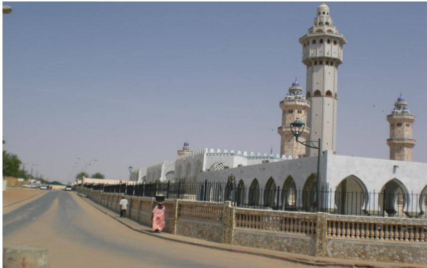
c) La Grande mosquée de Touba aujourd'hui en perpétuelle rénovation— toujours au centre mais dans l'urbs. (Djib Faye 2009)
