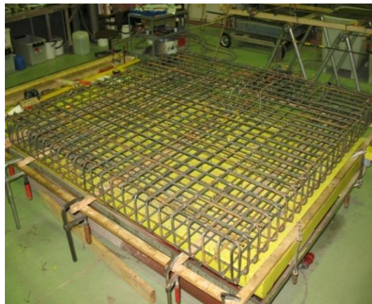
Figure 4-45. Ferrailage dans la dalle en béton armé
