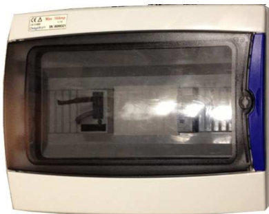
Figure 4.2: Wattmètre Omegawatt v1
