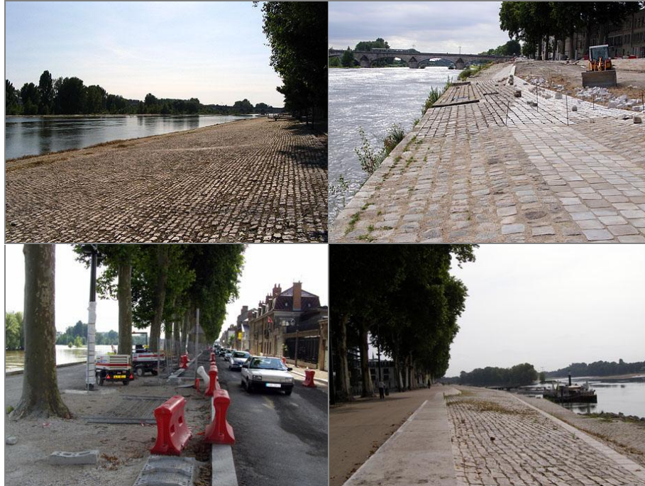
Planche 56 : les quais hippomobiles avant, pendant et après travaux de requalification
