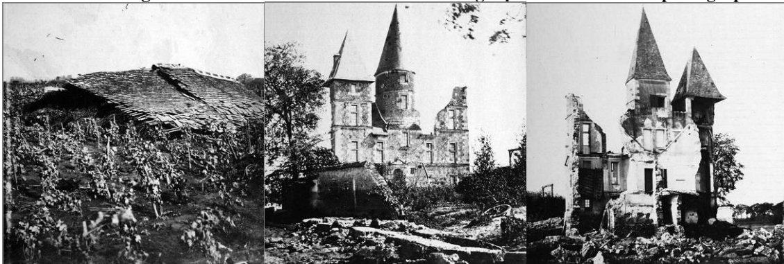
Planche 46 : dégâts de la crue de 1866 en Val d'Orléans figés par les débuts de la photographie
