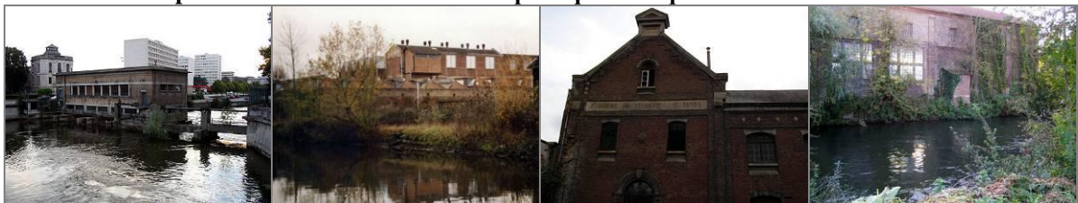
Planche 55 : le patrimoine industriel exclu de la politique de requalification des milieux d'eau à Amiens
