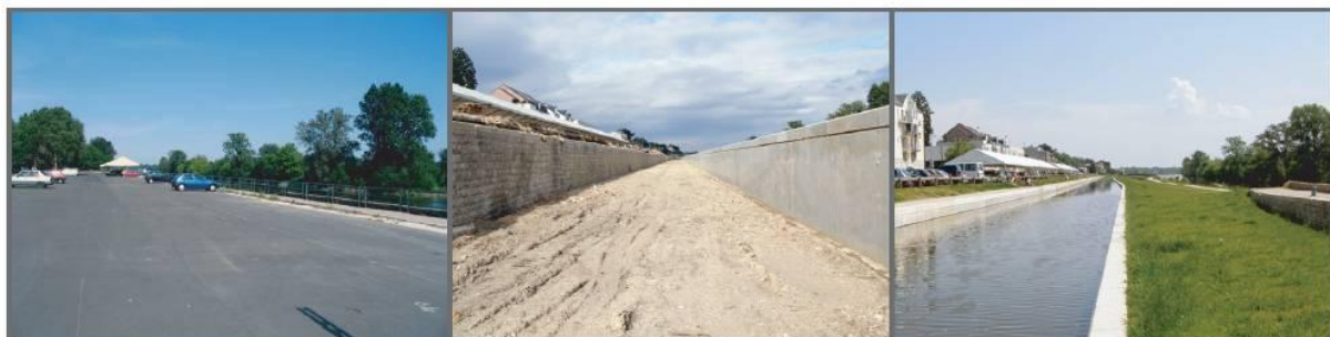
reconstitution réduite du canal d'amenée au quai du Roi : 9 m de large ; 1,5 m de tirant d'eau (cl. ibid. )
