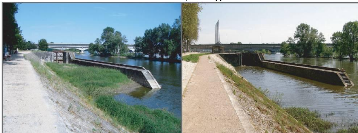
curage du bassin en Loire, reconstitution d'écluse et capitainerie (cl. S. Dournel : 08/06/2005, 07/05/2008)
