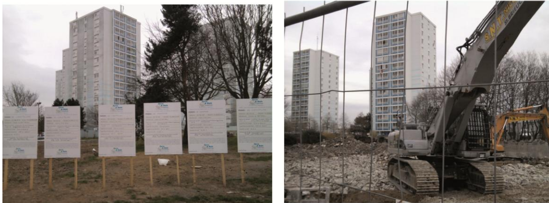
Les sites de la reconstruction à La Croix-Lambert au moment de la mise en chantier des opérations de démolition des tours, 7 février 2011
