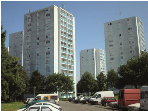
Vue du parking, rue Jules Vallès les tours de la Croix-Lambert avant les opérations de rénovation urbaine, Saint-Brieuc, Aout 2009
