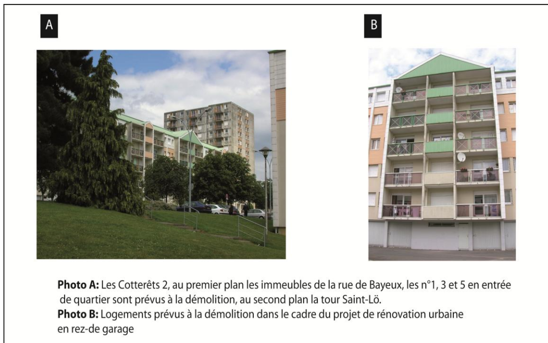
Figure 4.9 – Le quartier des Cotterêts 2 à Fougères
