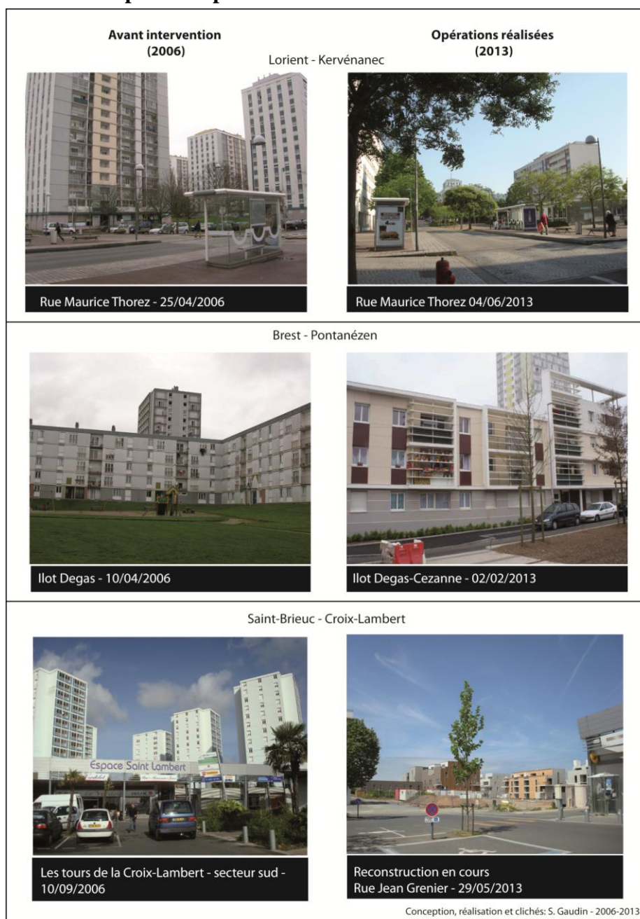
Figure 4.6 - Brest, Lorient et Saint-Brieuc - trois paysages urbains des ZUS bretonnes avant et après les opérations ANRU
