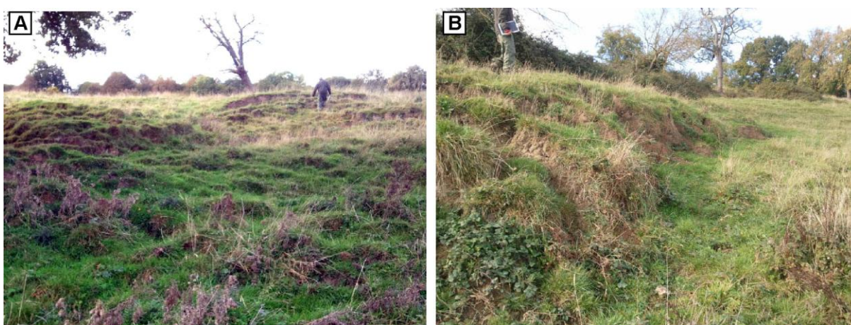
(A) vue sur l'escarpement principal et (B) vue sur le lobe frontal du glissement (Reulier, novembre 2011)
