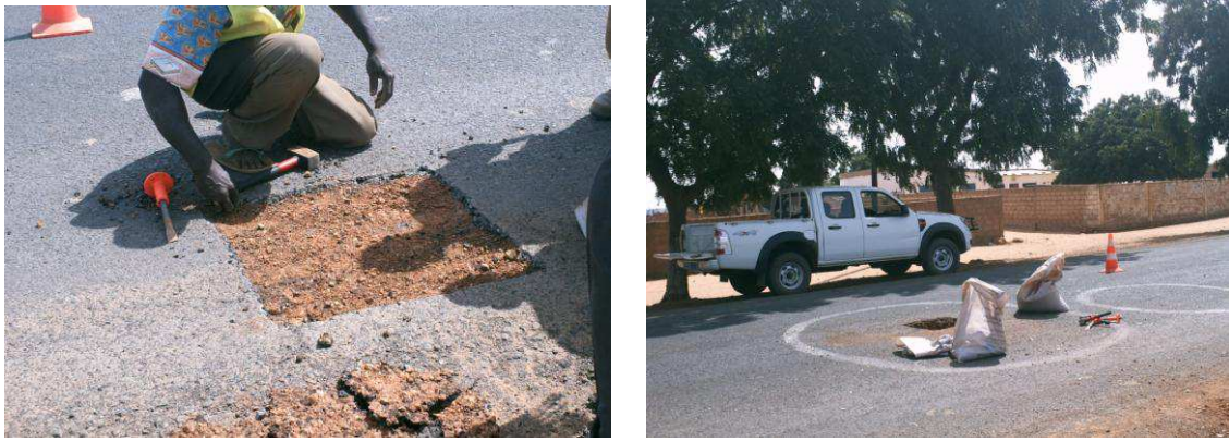
Figure 2.4. Prélèvement sur le tronçon Mboro – Diogo
