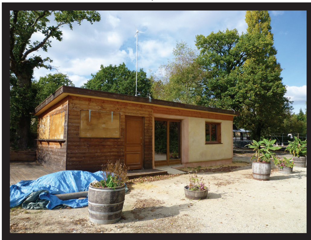
PHOTO N°2 : LE PROJET ECO-CONSTRUCTION
