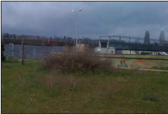
Photographie 18 : Station d'épuration intégrée dans le paysage avec sculptures effémeres, rucher entretenu par les scolaires, RB Fontainebleau-Gâtinais
