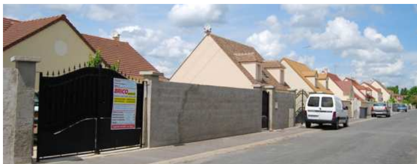
Photographie 3: Lotissement récemment construit (RB Fontainebleau-Gâtinais)
