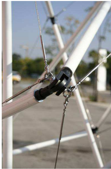
Figure 67. Vue d'un nœud laissant apparaître des jeux importants, générateurs de flexions parasites
