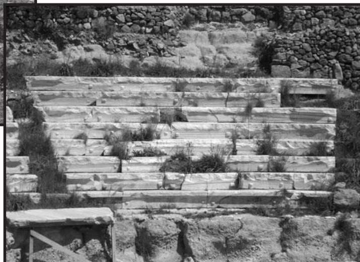
**Fig. 3.** Gradins en marbre (tenons de bardage non ravalés) et gradins creusés dans la roche.
