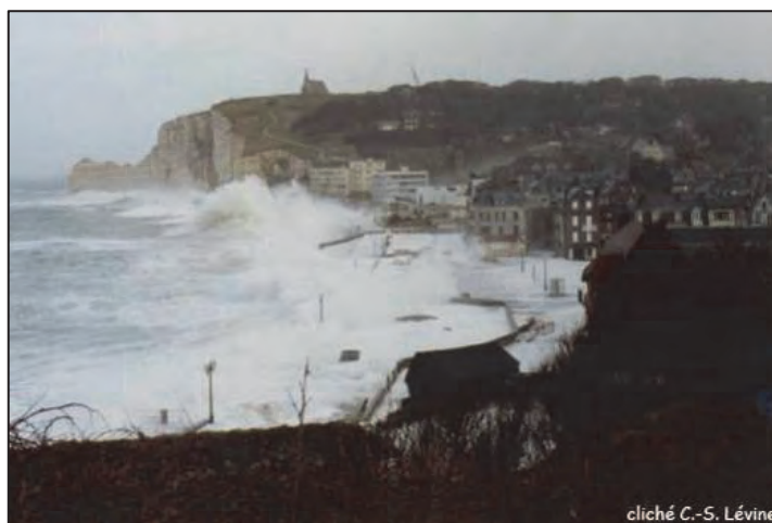
Figure 13.14 : Franchissement des vagues lors de la submersion du 27/02/1990 à Étretat
