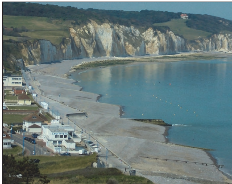
Figure 1.15 : Cordon de galets adossé au perré à Pourville-sur-Mer (commune d'Hautot-sur-Mer) (Letortu, 28/06/2010)
