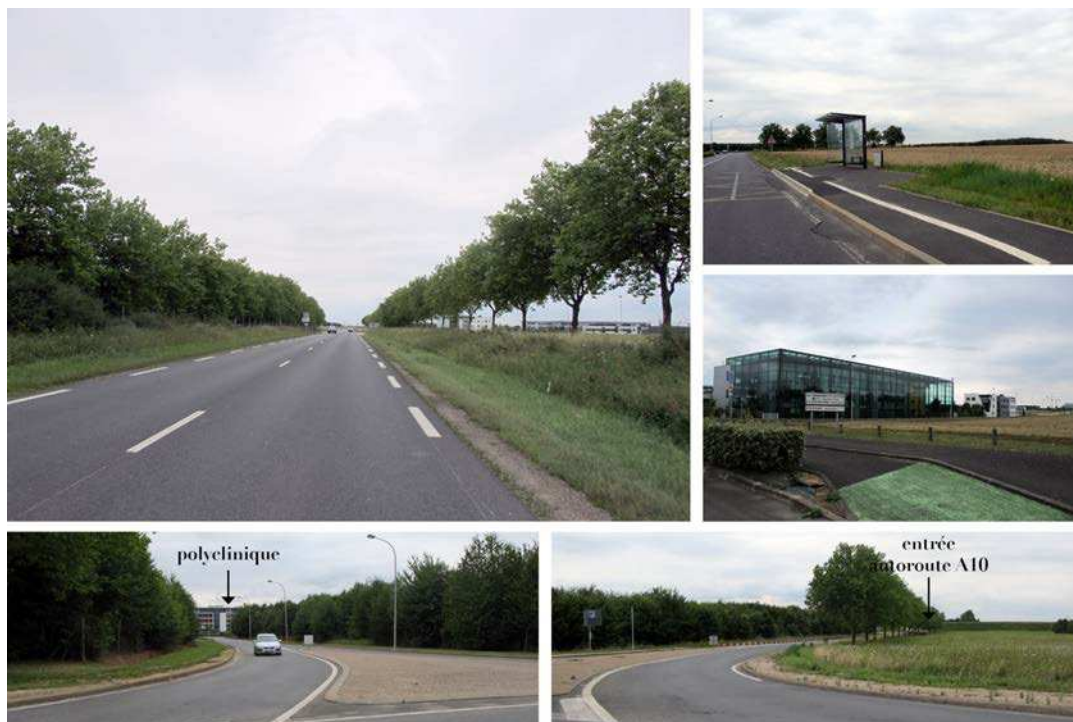
Figure 45 : Le « parc A10 » en 2012. En bas, des photographies de l'entrée de parc A10. On y voit le préverdissement et le bois ainsi constitué entre la polyclinique et l'entrée de l'autoroute.
