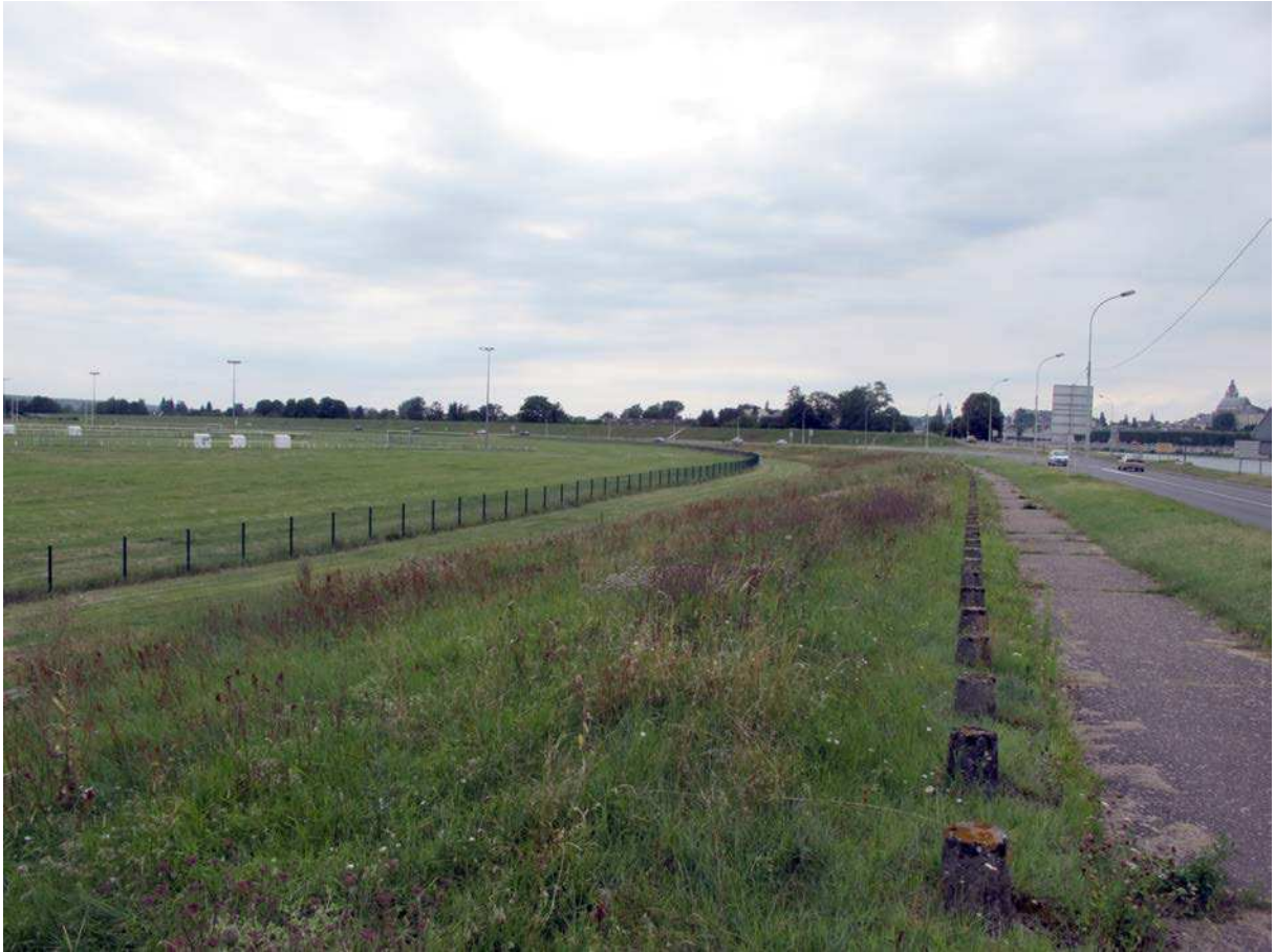
Figure 43 : Le déversoir de la Bouillie en amont du quartier endigué de Vienne (en face), l'entrée du déversoir est occupée par des équipements sportifs. (Photo L . VOISIN 2012)
