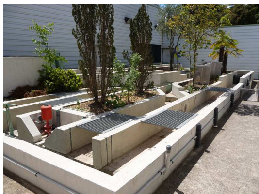
(a) Vue générale du grand canal de l'ENSAM
