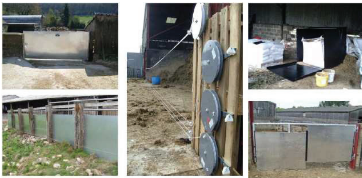
Figure 64 : exemples de dispositifs visant à protéger les infrastructures d'élevage contre l'intrusion de blaireaux (Source : Judge et al. 2011)
