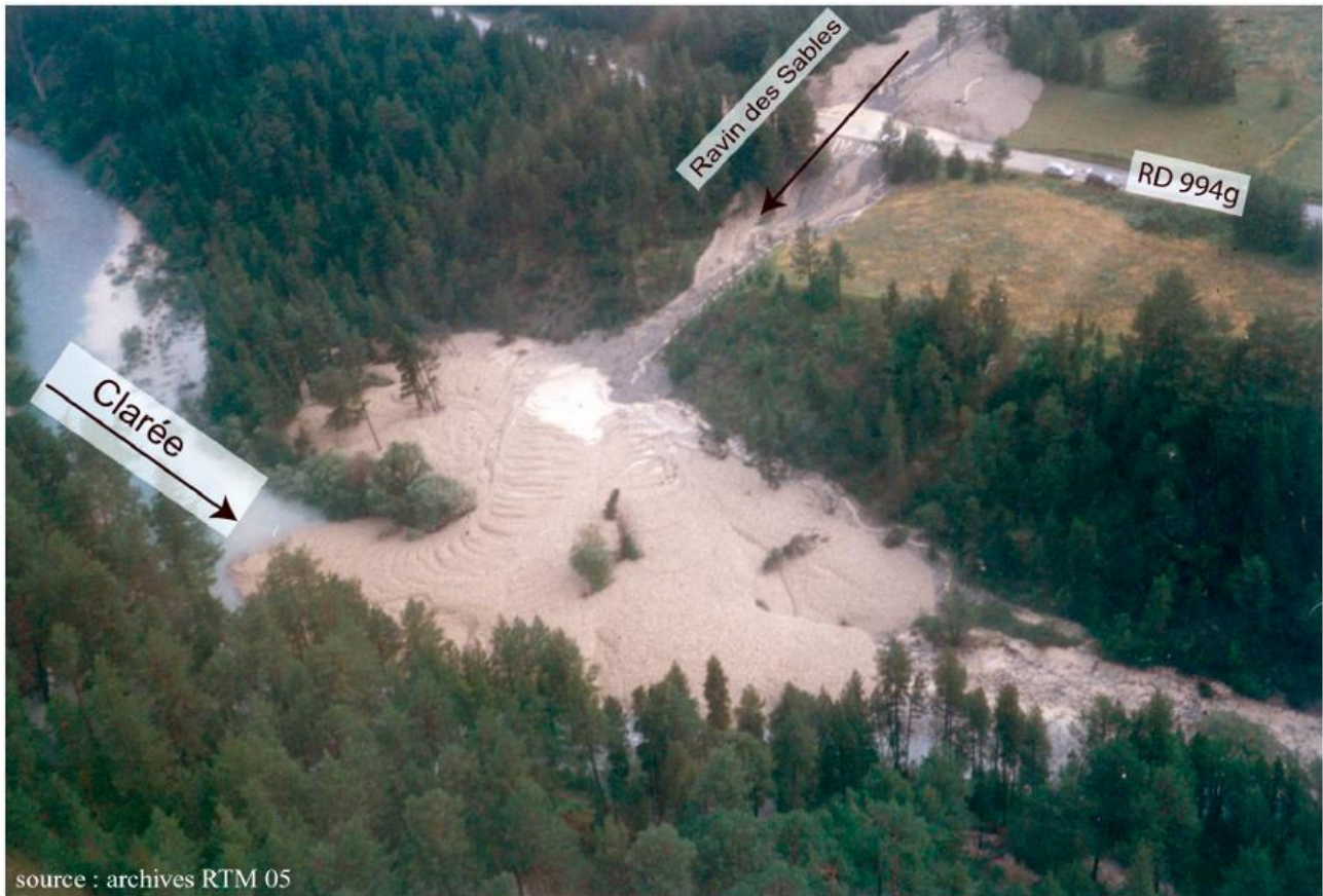
Figure 12 : Exemple de phénomène d'obturation, faisant suite au déclenchement d'une lave torrentielle dans les Alpes du Briançonnais.
