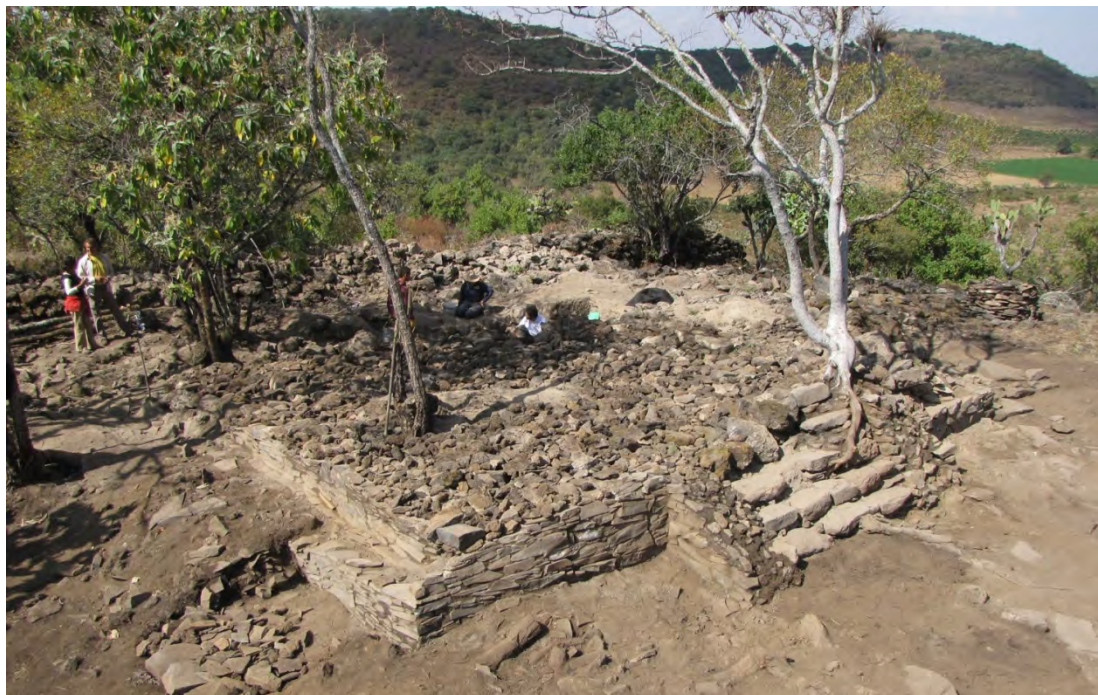
Figure 94 : Vue générale, depuis le sud-est de la plate-forme S3, après consolidation (Cliché : G. Pereira).
