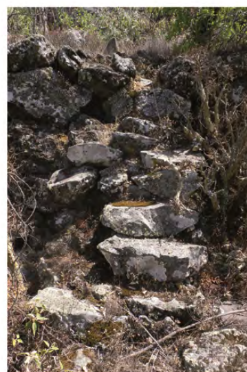
f - Aménagement d'accès (petit escalier fait de grands modules de basalte)
