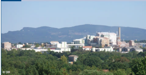
FIGURE 1 ZONE INDUSTRIELLE DE SALINDRES (GARD)
