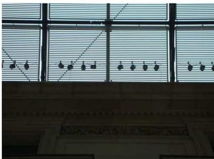
Spots d'éclairage situé au niveau de la verrière. L'éclairage principal de la salle la nuit est fourni par ces rampes de spots qui font le tour de la verrière.
