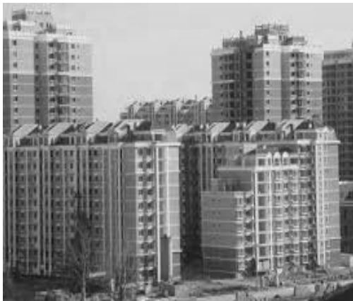
située à 25 km au nord de Pékin, la cité Tiantongyuan est hérissée de gratte-ciel
