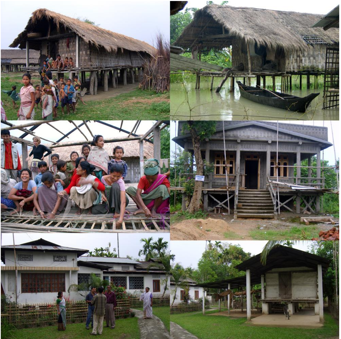
Planche photo 12 : Différents types de maisons mising. 1- Maison mising en bambou ; 2- Maison sur pilotis en bambou pendant les crues ; 3- Construction d'une nouvelle maison ; 4- Maison en ciment imitant les maisons en bambou sur pilotis ; 5 et 6- Maison en béton, sans pilotis de type assamais, avec un grenier à riz sur pilotis construit avec des cloisons en bambou recouvertes de boue.
