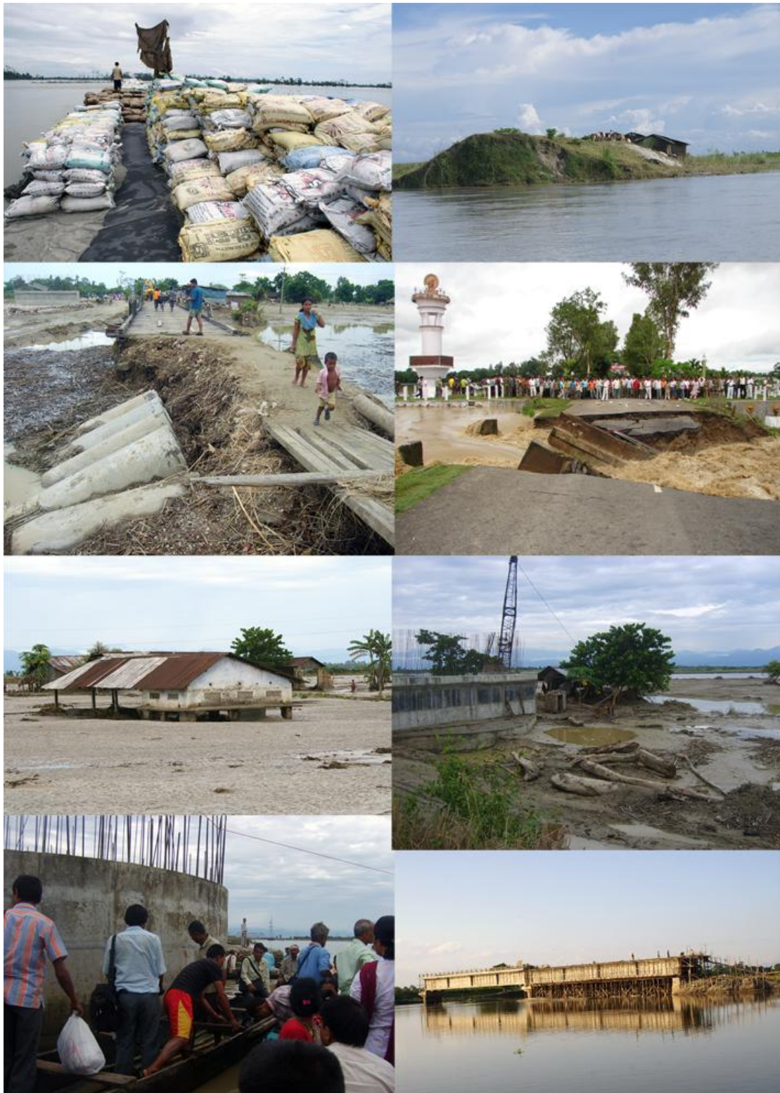
Planche photo 31 : Dommages sur les infrastructures publiques (routes, ponts, écoles, lieux de culte) 1- La digue de Matmora s'est rompue en 2008 sous la pression du fleuve et l'érosion des berges. Les autorités territoriales et les villageois tentent de renforcer la digue à l'aide de sacs remplis de sable. 2 - Le village de Baligaon s'est réfugié sur un fragment de digue. 3 et 4- Les rivières traversant le district de Lakhimpur ont coupé la route nationale NH52 en plusieurs points. De juillet à septembre 2009, la capitale du district de Lakhimpur se retrouve isolée du reste de l'Assam. 5- Les bâtiments publics sont endommagés par les inondations et des dépôts de sable de plus de 2 mètres pouvant recouvrir le village. 6, 7 et 8- Les travaux de construction des routes et des ponts sont suspendus pendant la saison des pluies.
