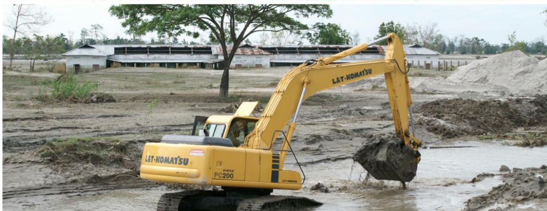
Dessin 15 et photo : Sri Bikeswar Doley du village de Matmora, class IX, 13 ans : «1- Les gens se sont réfugiés sur le toit en raison de l'inondation. 2- Un homme court après son cheval. 3- Les malais remplissent les géotube avec leurs machines.» La photo associée à ce dessin montre le travail d'une pelleteuse construisant la nouvelle digue de Matmora en octobre 2010. En second plan, l'école de Matmora est ensablée.
