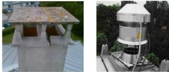
**Figure 4.2 : Photos des extracteurs utilisés lors du suivi annuel : cape à l'italienne (à gauche) et extracteur stato-mécanique (à droite)**
