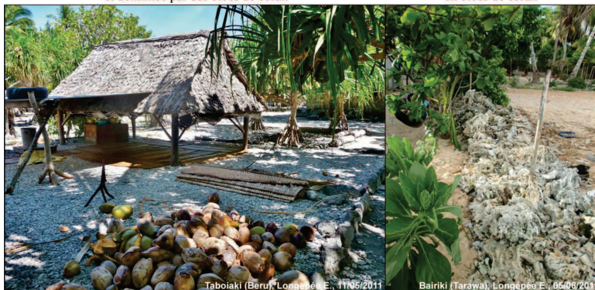
Mur de protection contre la mer en blocs de corail
