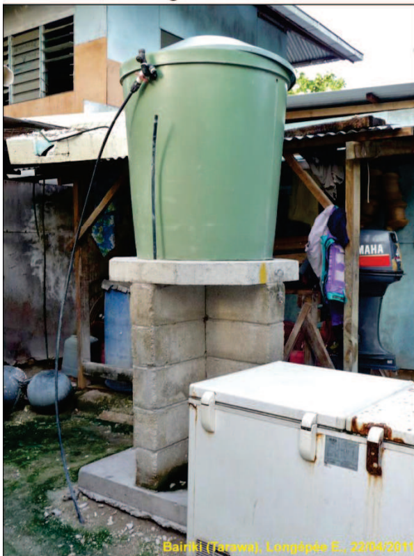
Citerne de stockage de l'eau du réseau d'eau
