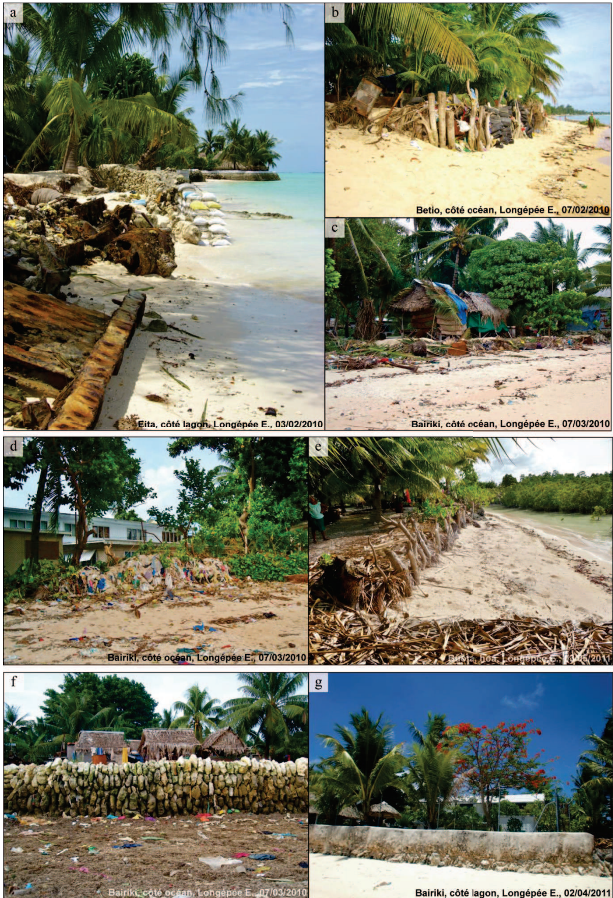
a. déchets de guerre, puis mur en sacs de sable ; b. structure en troncs, branchages et pneus comblée par des déchets ménagers ; c. protection légère composée de palme végétale et de déchets ; d. déchets ménagers ; e. branchages ; f. blocs de corail ; g. blocs de corail cimentés.
