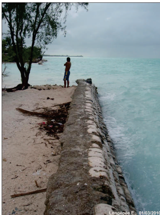
Photographie 19. Brèche dans le mur du Gouvernement sur la côte côté lagon à Eita.
