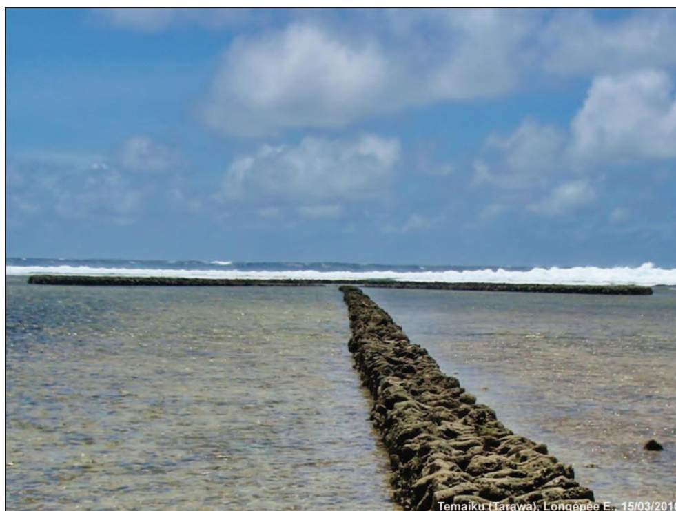
Photographie 37. Écluse à poisson encore entretenue sur le platier récifal de Temaiku (Tarawa Sud).
