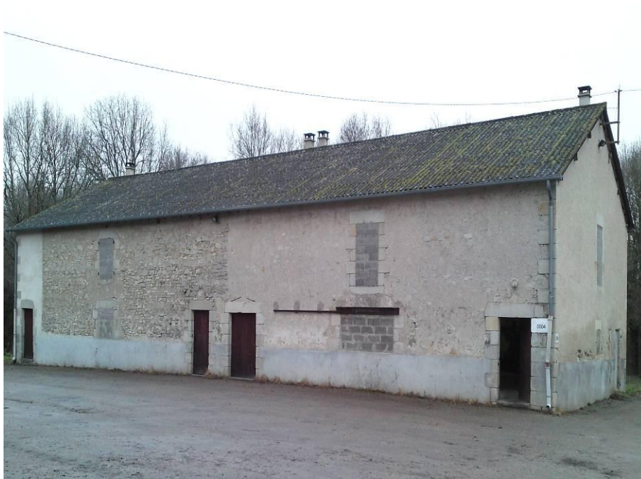
Illustration 25 : Bâtiment servant de lieu de rassemblement sur le terrain d'entraînement de Montmorillon novembre 2006.
