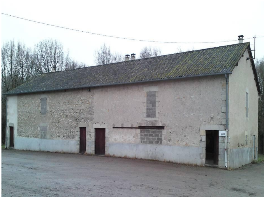
Illustration 25 : Bâtiment servant de lieu de rassemblement sur le terrain d'entraînement de Montmorillon novembre 2006.
