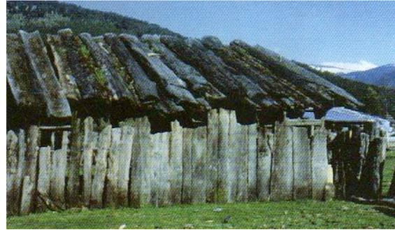
Figure 13, A gauche, la Ruca Williche, normalement de plan carré, a ses murs bardés dans le sens horizontal et son toit incliné en paille. A droite La Ruca Pewenche de plan carré est matérialisé complètement (toit et murs) en bois sous forme de canoës. Cette matérialité permet de bien supporter le poids de la neige cumulé sur la toiture pendant les périodes froides. Cette ruca correspond au territoire de montagne. Photos (Ministerio de Obras Públicas, 2003)
