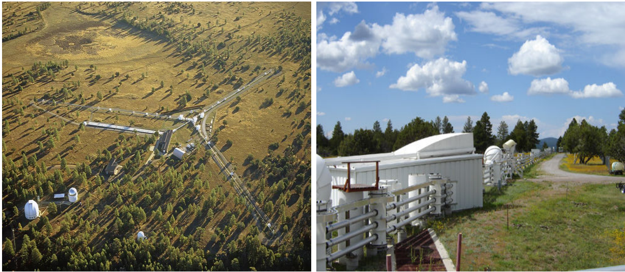
Figure II.19 – Gauche : Vue aérienne de l'interféromètre NPOI avec sa configuration en Y. Droite : Un de trois bras interférométriques de NPOI composé de trois télescopes.
