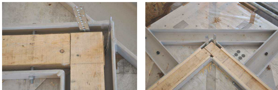
(a) Positionnement du cadre dans le profilé métallique (b) Serrage des lisses par l'intermédiaire de cale en bois et de tige filetées boulonnées
