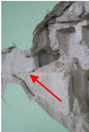
(a) Le mortier se désagrège facilement et son épaisseur entre les parpaings est réduite au maximum, Haus et al. [81]
