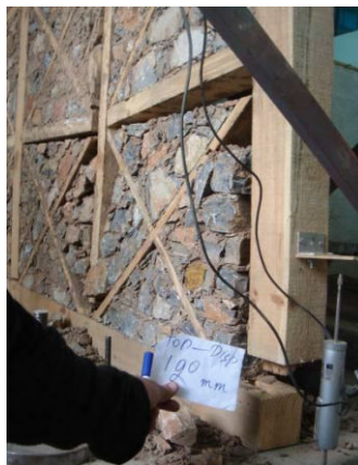
(b) Expérimental : rupture de l'assemblage type-1, [5]
