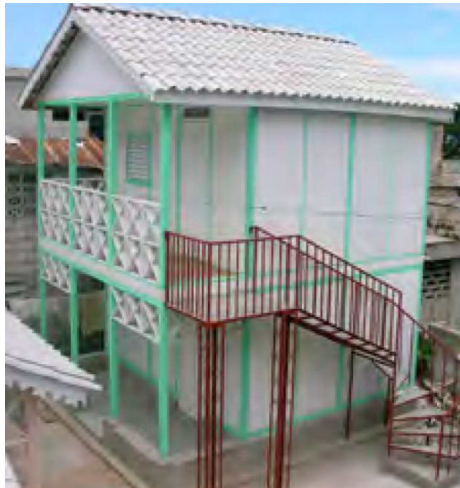
(a) Bâtiment construit non loin de Port-au-Prince, Haïti (projet de construction de l'ONG Entrepreneur du Monde)
