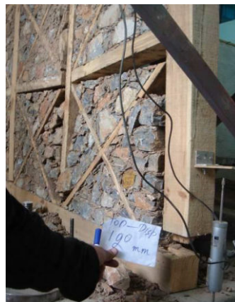
(b) Expérimental : rupture de l'assemblage type-1, [5]
