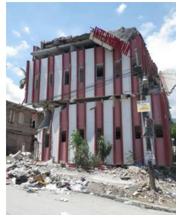
(c) Perte du deuxième étage et du rez-de-chaussée par effet de transparence, Haus et al. [81]
