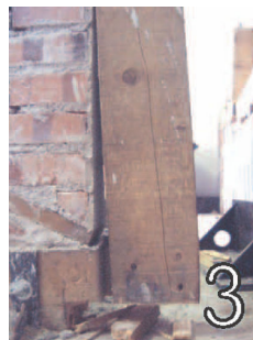
(b) RB : grande déformation de l'assemblage en pied
