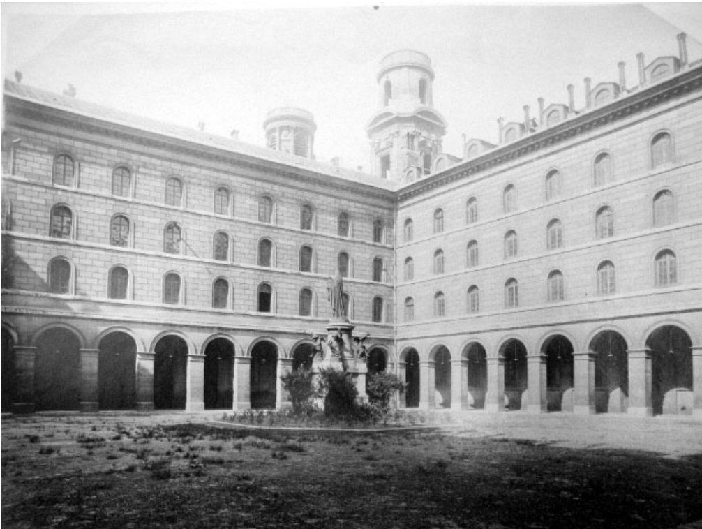
Illustration 115: Séminaire de Saint-Sulpice, vue d'un des couloirs desservant les niveaux de cellules, (haut) et vue du cloître (bas), tirages argentiques, s.d. [ca. 1904-1905] (Arch. Mus. nat., 2HH4).
