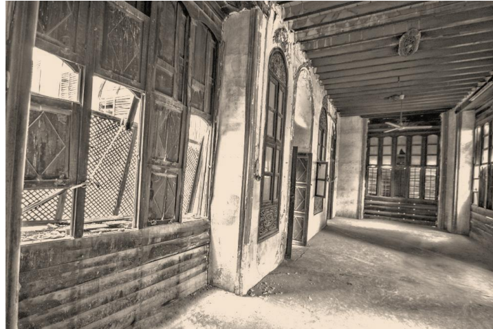
Figure 3-12 : vue intérieure de la salle de séjour dans une maison traditionnelle à Djeddah. Ici, l'éclairage solaire ne rentre pas directement dans la pièce, elle est éclairée de façon indirecte ; [AlHajj Photographe, 2012].
