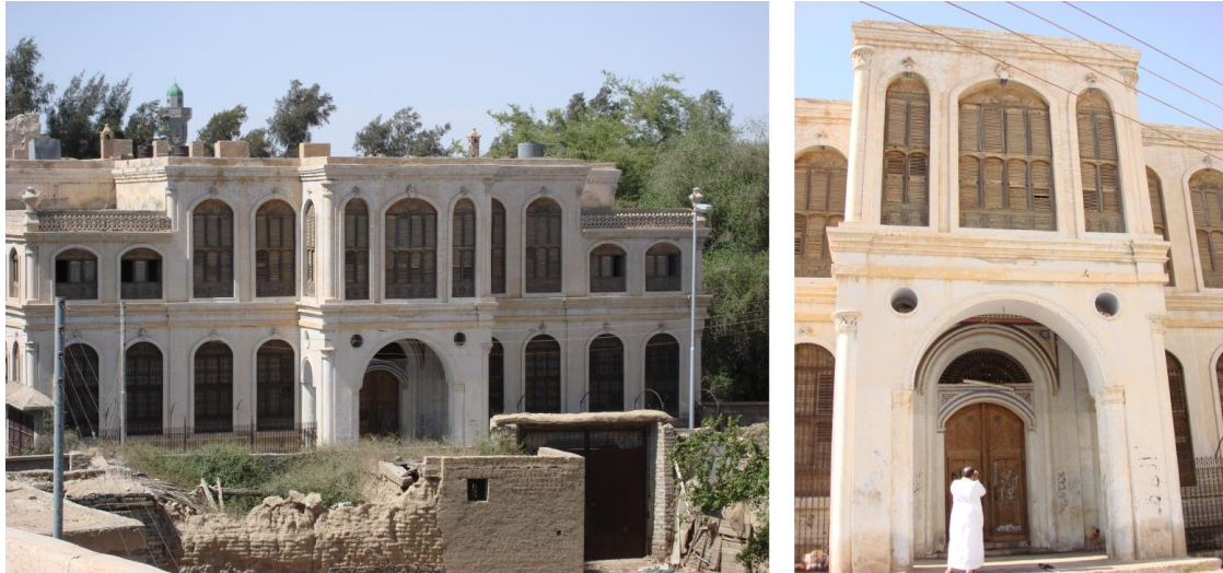
Figure 3-10 : la grande maison d'Al-Bougari à Taïf, dans laquelle d'autres types de moucharbieh ont été installés pour pouvoir s'adapter au climat de la région (la maison de mon grand-père) ; par l'auteur.
