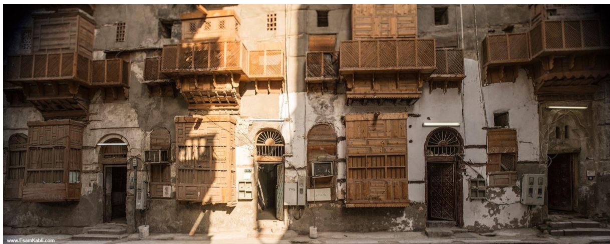
Figure 3-14 : la projection des rowshans aide diminuer la rayonnement solaire sur les façades également à augmenter l'espace intérieur ; par [Kabli photograph, 2012].
