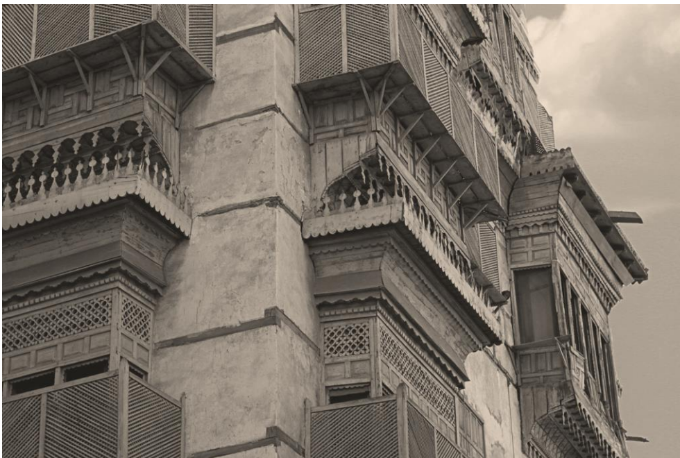
Figure 6-22 : Des systèmes de rowshan sur une façade, on observe une porosité élevée dans l'habitat traditionnel; par l'auteur.
