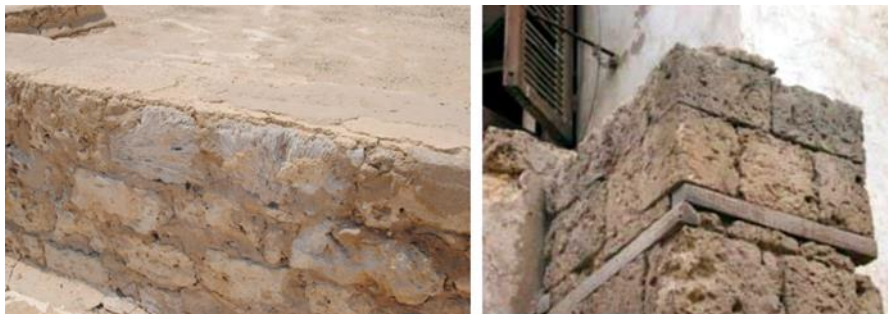
Figure 5-10 : Types de pierres en corail utilisées dans les bâtiments à la vieille ville de Djeddah ;[AIDAROUS 2011].
