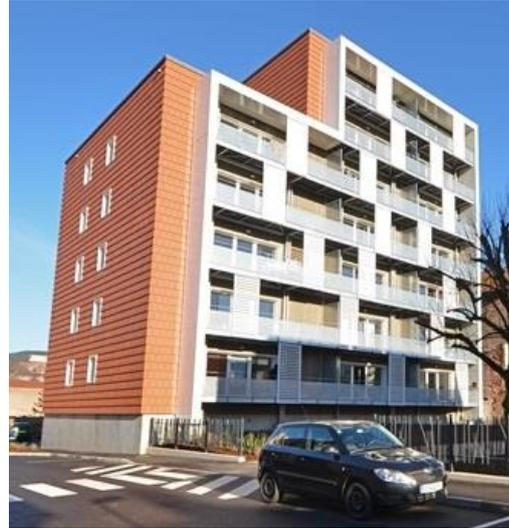
Figure 11 : Immeubles bois en panneaux de bois lamellé croisé (CLT)
