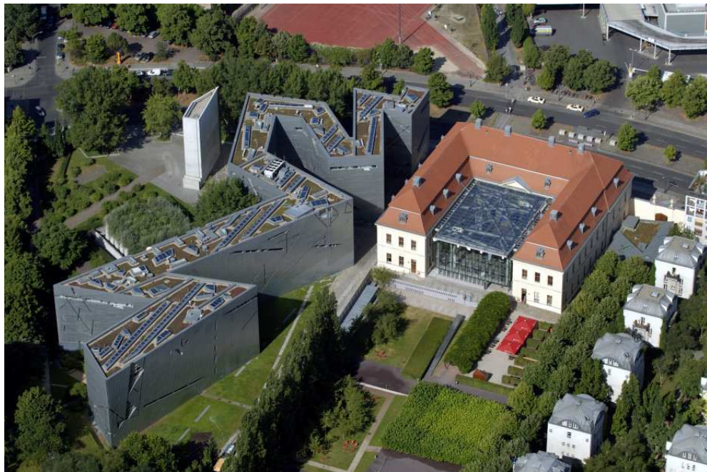
Figure 26. En haut : le traitement fragmenté des fenêtres avec les ouvertures linéaires qui se croisent et qui créent des fragments en forme de cicatrice sur la façade. En bas : la forme en zigzag du musée, et à droite, le bâtiment baroque, où se trouve l'entrée du musée.
