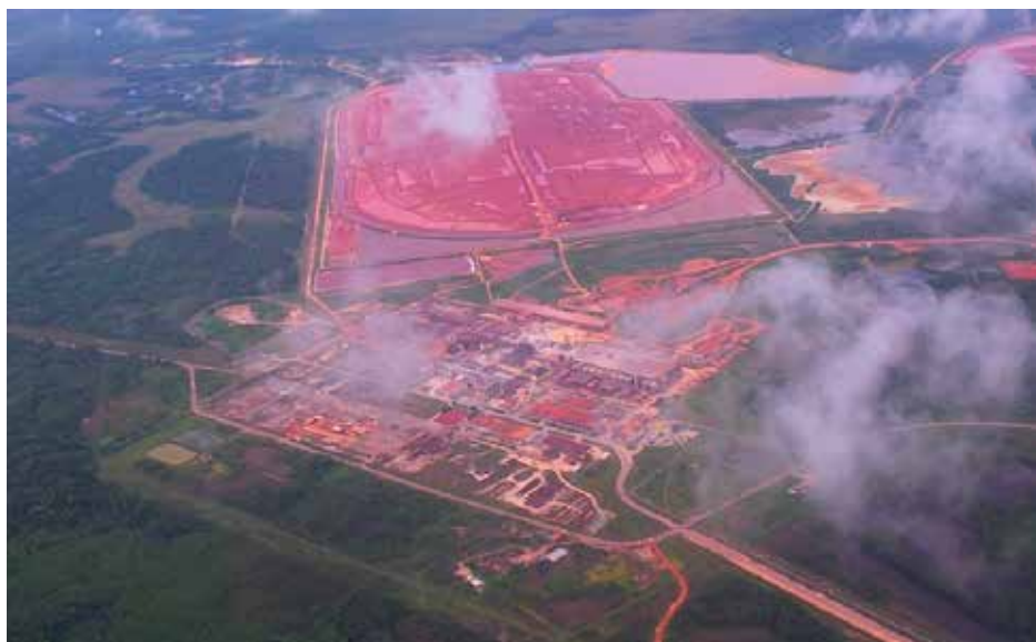
Figure 2 : La zone de l'entreprise minière Suralco : le rouge au milieu du vert de la forêt.
