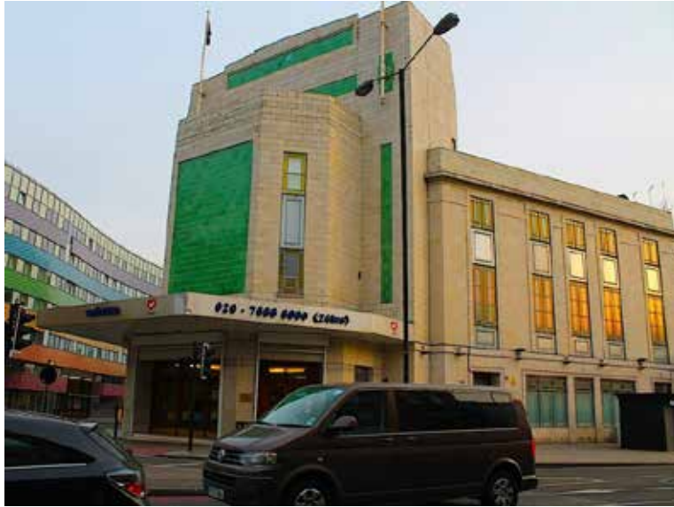
Figure 4 : Siège de l'Église Universelle du Royaume de Dieu (Universal Church of the Kingdom of God) à Londres, à l'angle de la Seven Sisters Road et d'Isledon Road.
