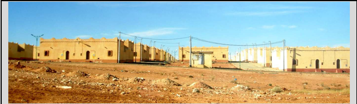
Photo -131- Juxtaposition de logements au niveau du nouveau pole de Bouhraoua (Ghardaia) photo Bachar k. 2013
