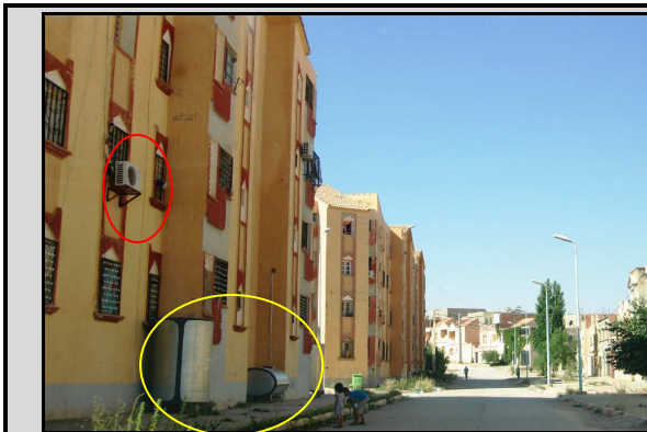
Photo -39- climatiseur et stockage de l'eau dans des citernes posées dans la rue, à même le sol
