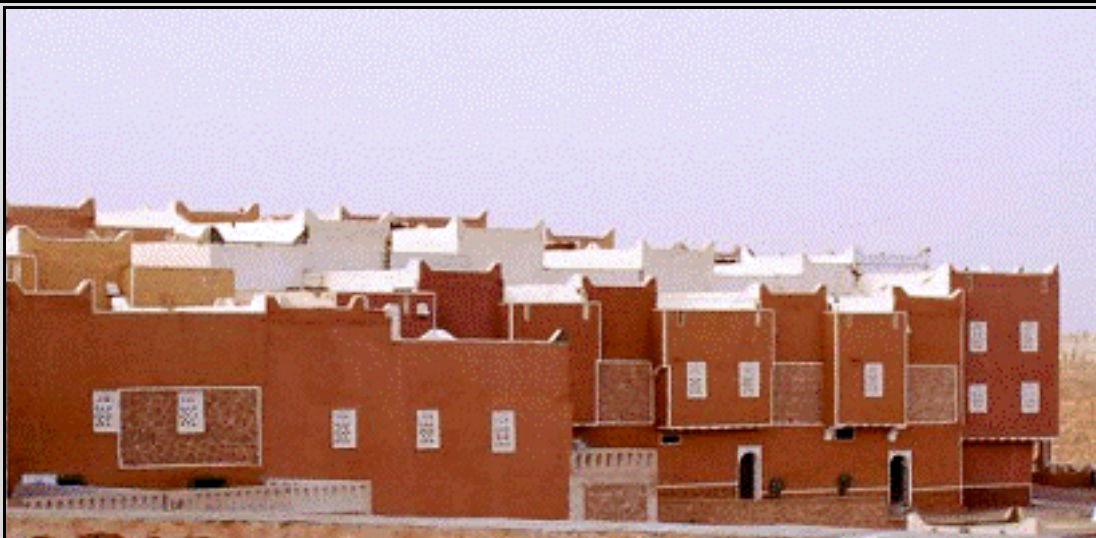
Photo -130- En conformité avec l'esprit égalitaire du rite ibadite, il se dégage des façades, une unité d'apparence et une égalité dans le traitement pour des maisons semblables mais non identiques.
