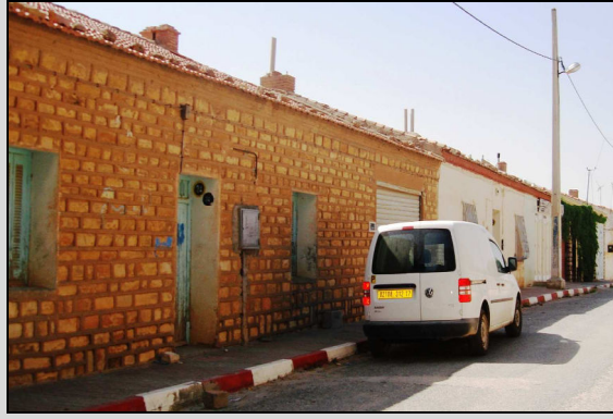
Photo -43- Maison individuelle en tuiles et pierres, datant des années 1900 photo Bachar k. 2013
