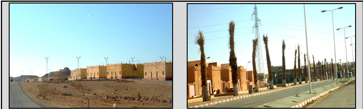
Photos -118- et -119- A Bouhraoua, nouvelles cités d'habitat le long d'axes routiers comme ici sur la RN1
