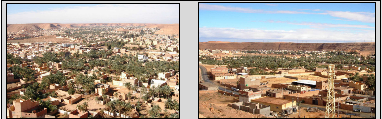
Photos -111-et-112-L'urbanisation envahit les palmeraies, ici à Ghardaïa et à Bounoura Photos Bachar k.2013
