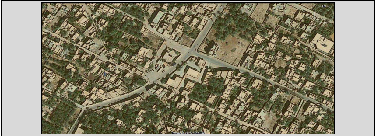
Photo -110- Dans la palmeraie, des quartiers se forment avec leurs réseaux routiers et infrastructures
