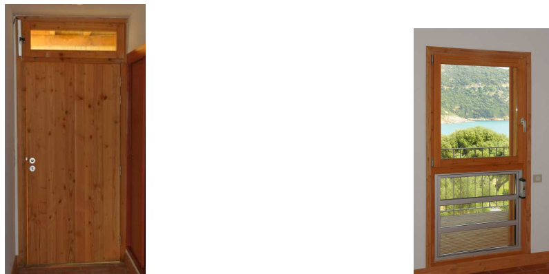
Figure 3.2 – Ouvertures A et B d’une chambre du bâtiment Charpak (pour la ventilation naturelle)
