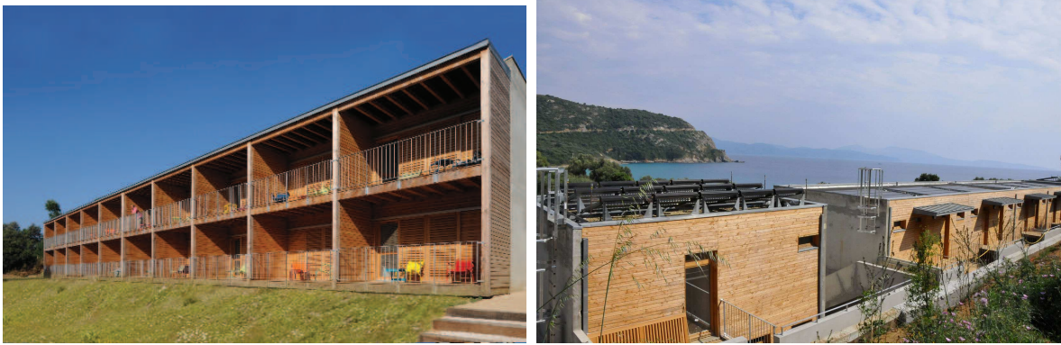
Figure 3.1 – Vue de l’extérieur du bâtiment Charpak
